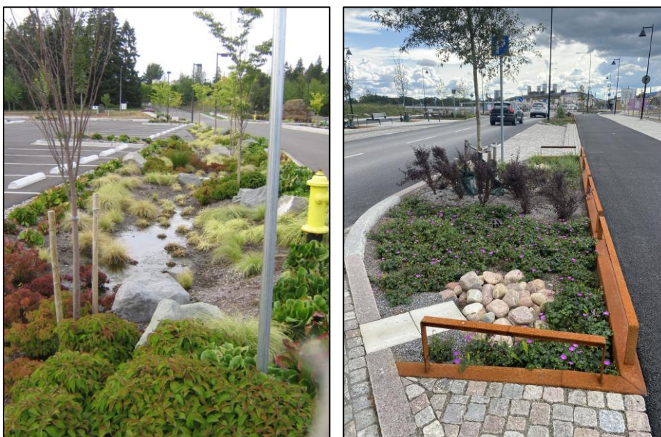
Figur 8.4. Exempelbilder på regnbäddar (Foto: NIRAS).
