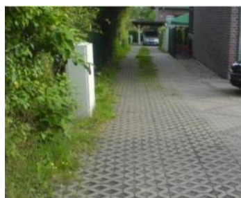
Bild 10. Till vänster: Exempel på gräsarmerad betongbeläggning. Till höger: Principskiss för genomsläpplig beläggning (Stockholm Vatten och Avfall, 2017) från Dagvattenutredning, WSP 2022-10-24
