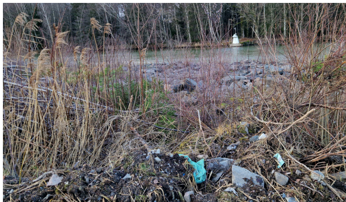
Figur 5.6 Foto från strandkanten fastigheten Stallbacka 4:5. En uppfyllnad som i alla fall toppas med block har lagts ut. (Foto: Katoen Natie Sverige AB, november 2023)
