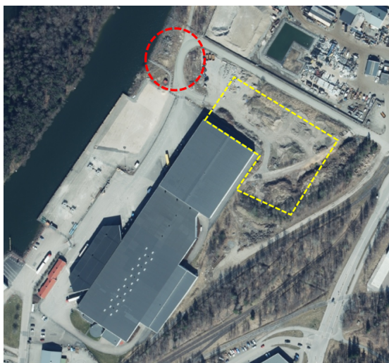
Figur 5.4 Det aktuella utredningsområdet från Stallbackahamnen i söder till fastighetsgräns i norr. Området längst i norr, där det idag inte finns någon kajkonstruktion är markerat med röd, streckad cirkel. Planerad tillbyggnad är schematiskt markerad med gul färg. (Bildkälla: Lantmäteriet Min karta)
