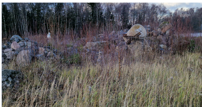
Figur 5.5 Foto från strandkanten fastigheten Stallbacka 4:5. En uppfyllnad som i alla fall toppas med block har lagts ut. (Foto: Katoen Natie Sverige AB, november 2023)
